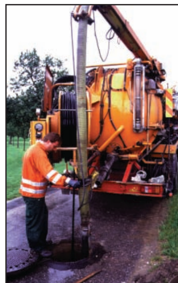
(zobrazení 16) vysokotlakové čištění
