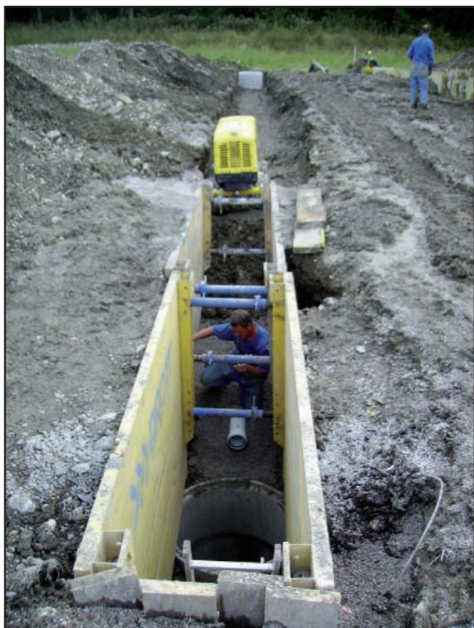
(zobrazení 11) „bvfs“ Zkušební vestavba
